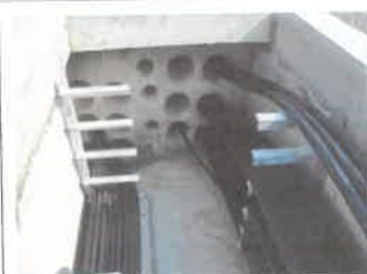
穿管电缆敷设
