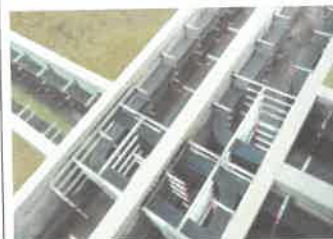
支架上电缆敷设（一）
