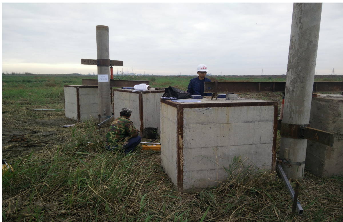
2.桩基检测试验
