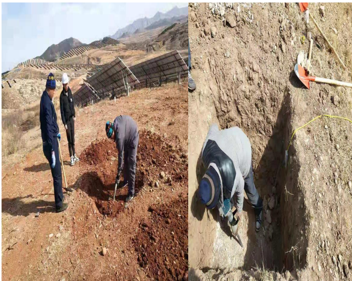
现场视频监控基础开挖
