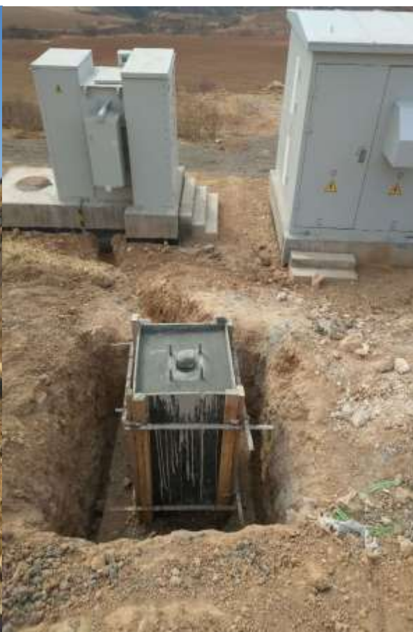
视频监控基础施工
