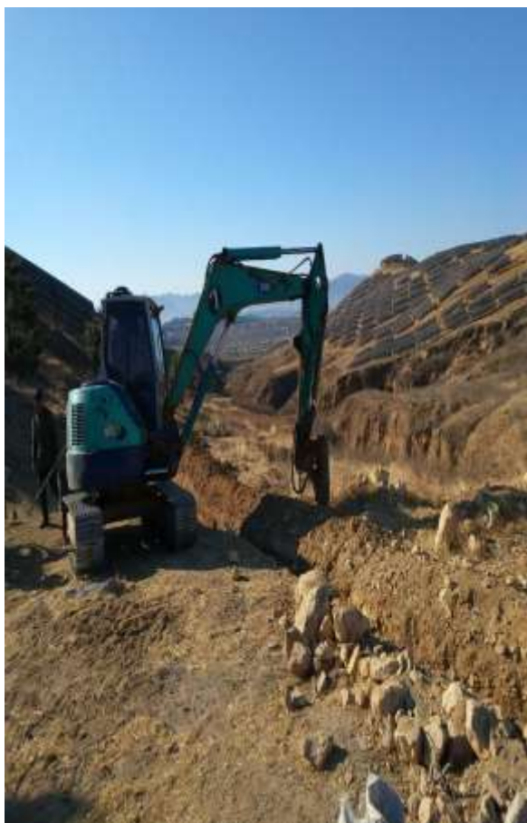
围栏柱基础施工
