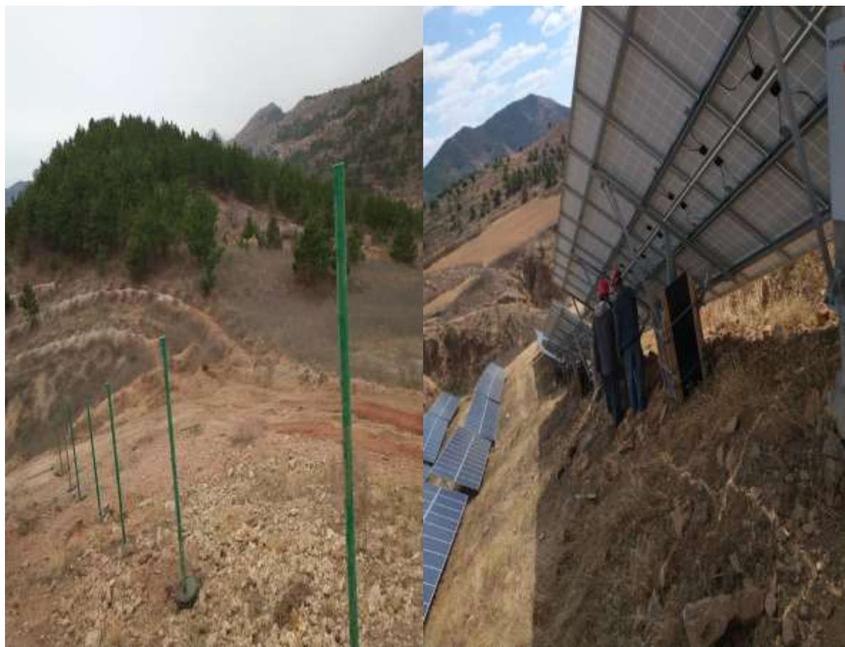
围栏柱浇筑施工
