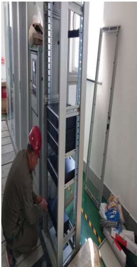
视频监控终端头施工
