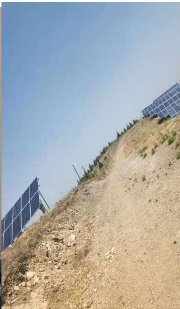
围栏施工现场
