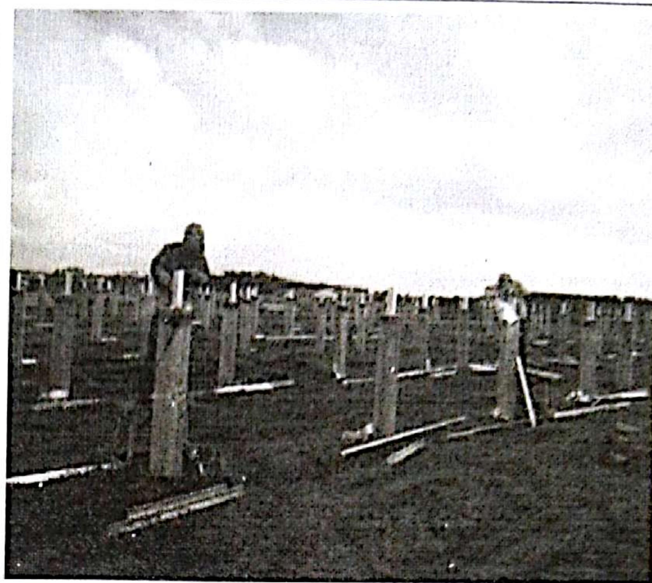
支架立柱焊接
