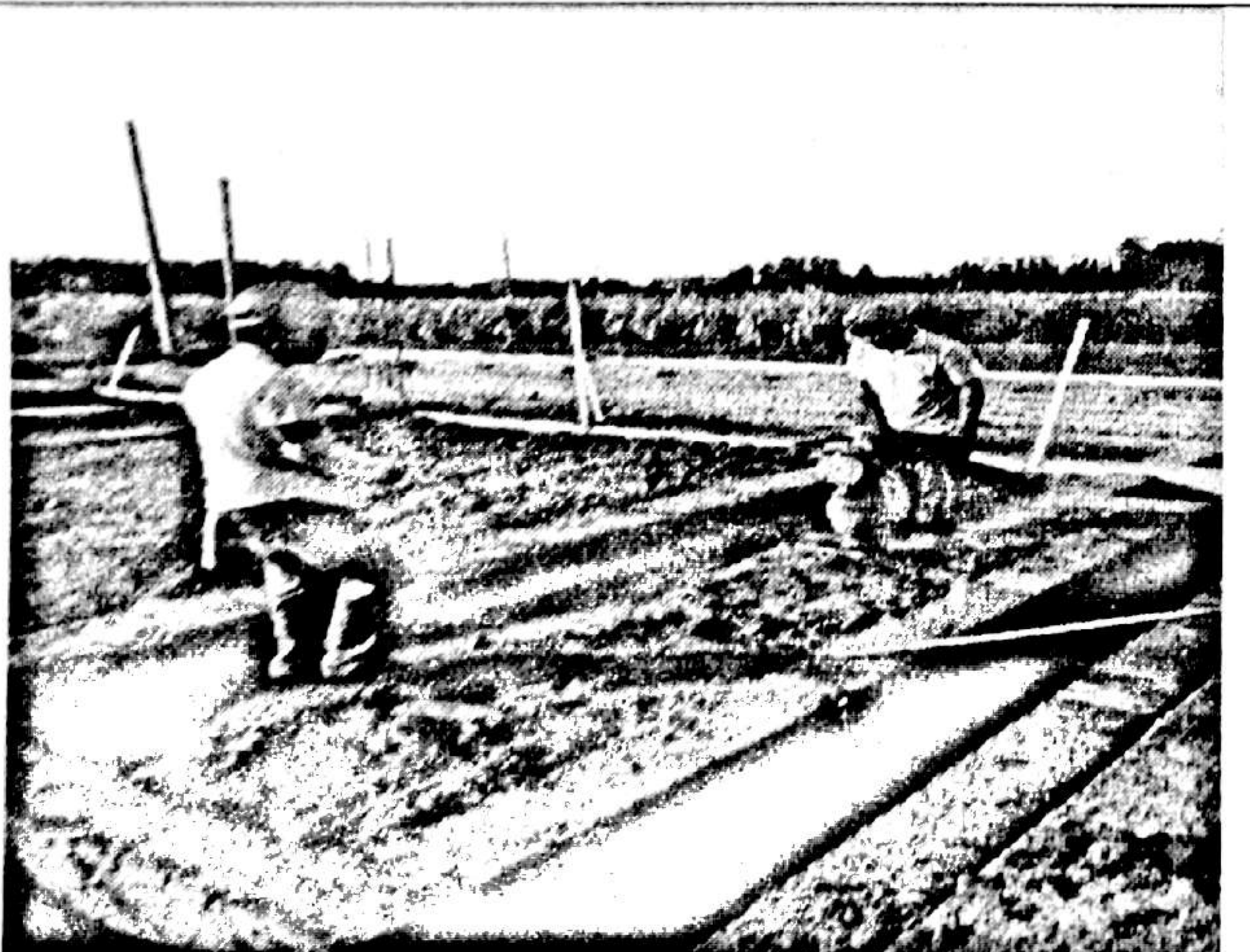
配电楼回填夯实
