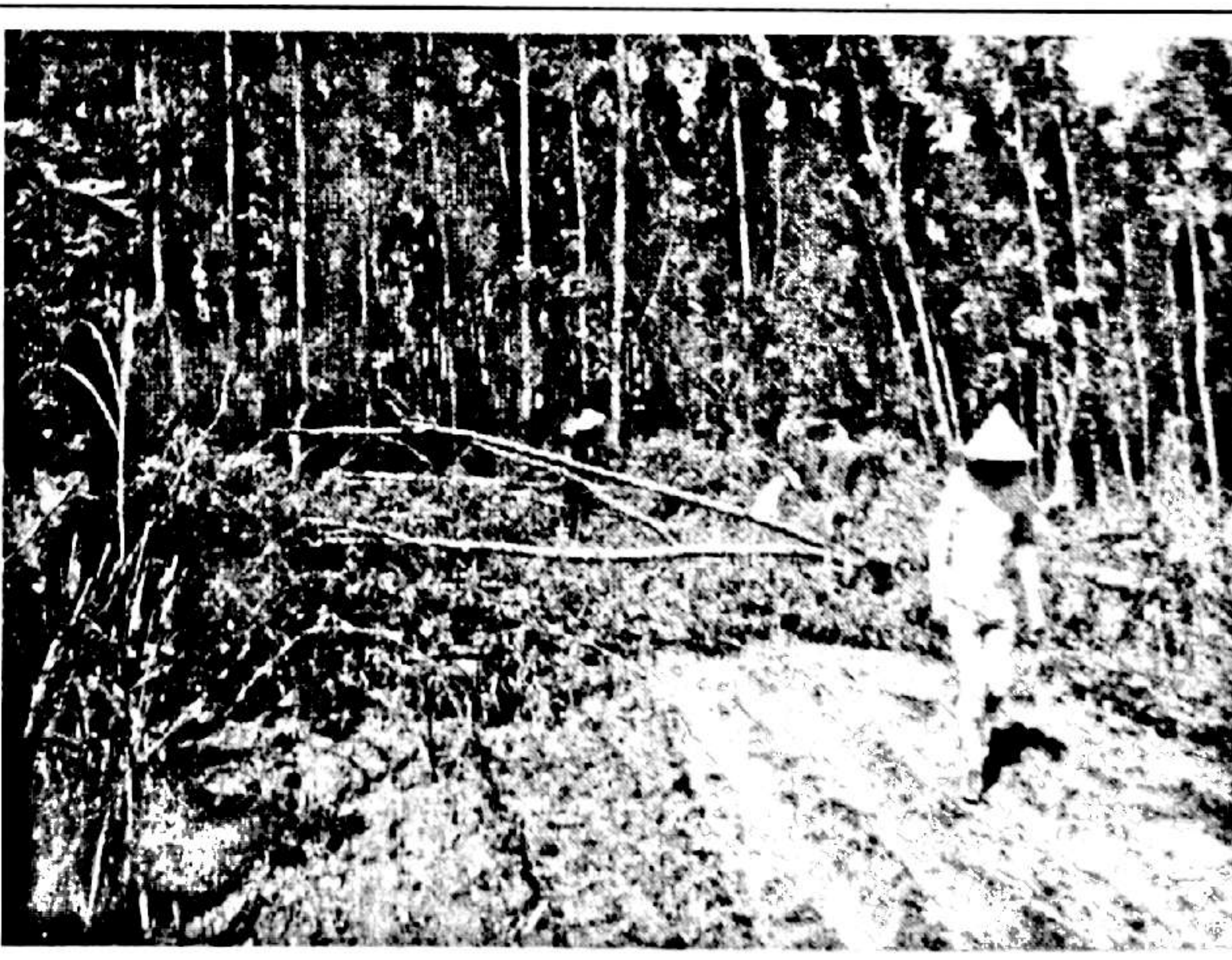
进场道路清理
