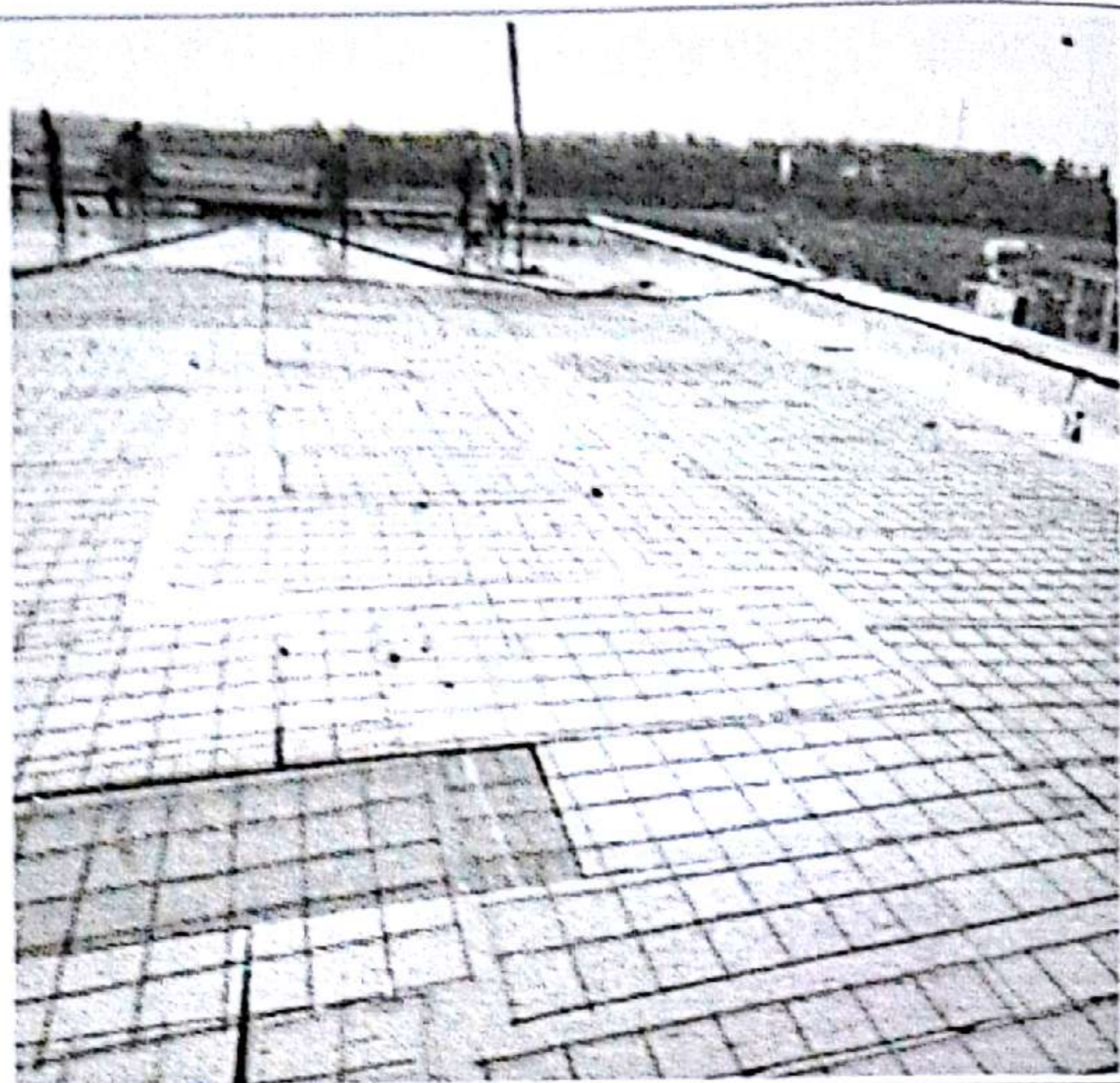
综合楼保温及保护层施工
