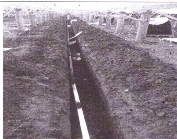
接地沟开挖+接地扁铁敷设
