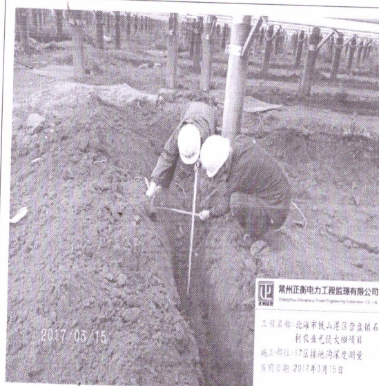
17 区接地沟深度测量
