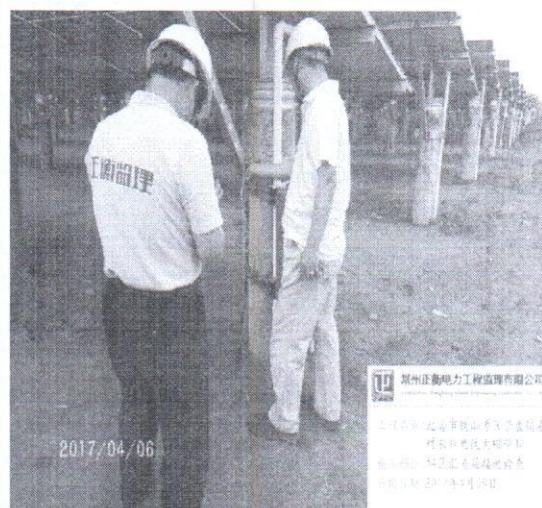
34 区支架安装螺栓检查
