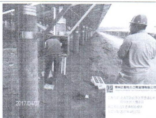
5 区更换汇流箱智能模块
