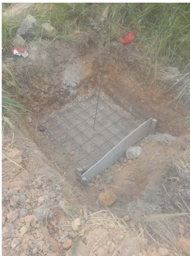
2017 年 09 月 12 日红联光伏区支架基础钢筋检查
