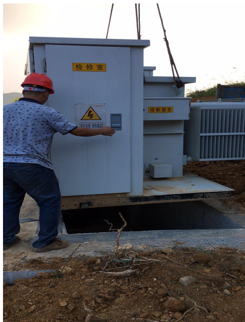
2017 年 09 月 13 日柏杨光伏区 17 子阵箱变安装
