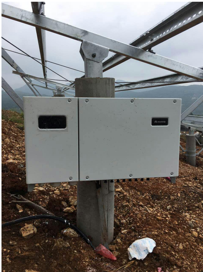
2017 年 09 月 20 日柏杨光伏区 17 子阵逆变器安装
