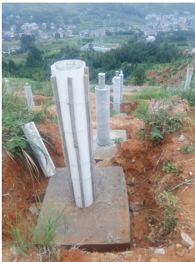
2017 年 09 月 21 日红联光伏区 12 子阵基础施工
