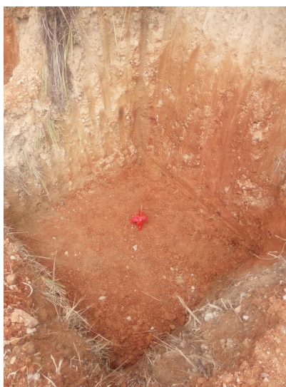
2017 年 9 月 24 日红联光伏区 12#子阵地地基验槽
