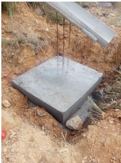
2017 年 09 月 25 日红联光伏区 12 子阵承台拆模检查
