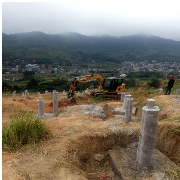
2017 年 10 月 6 日红联光伏区 12 子阵基础回填
