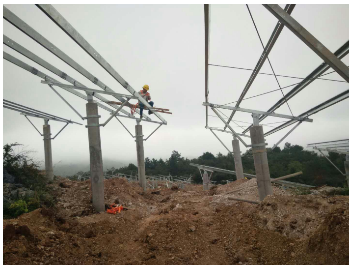
2017 年 10 月 06 日柏杨光伏区 18 子阵支架安装
