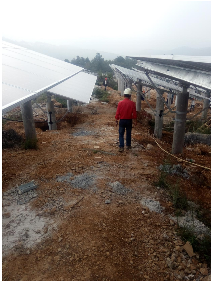
2017 年 10 月 10 日柏杨光伏区 18 子阵组件安装检查
