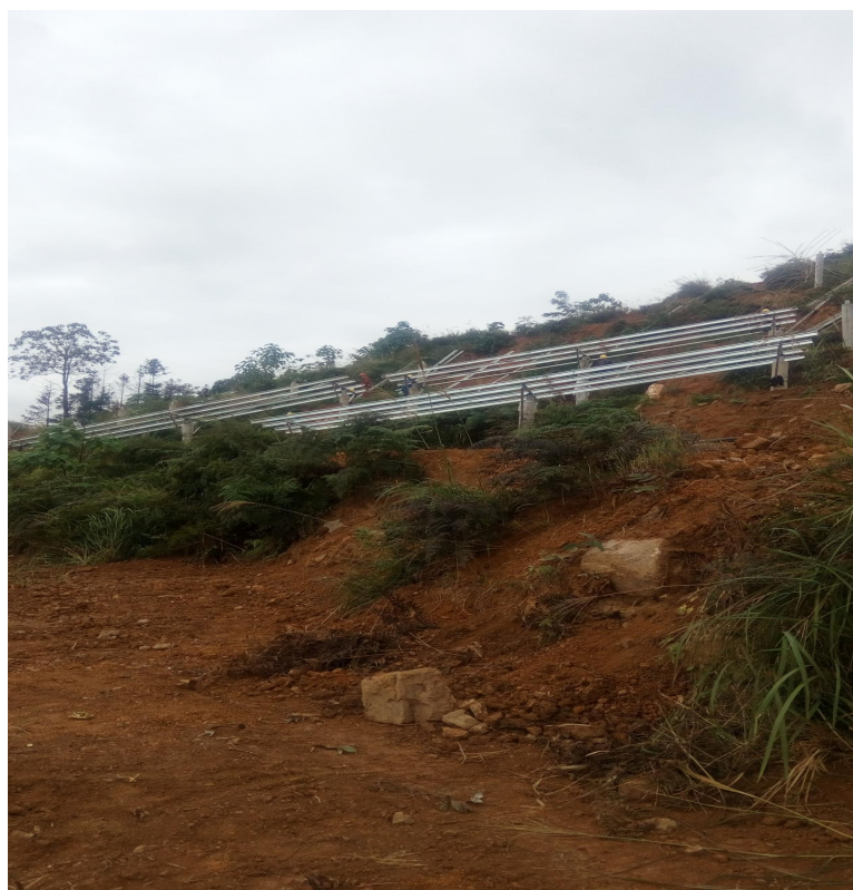
2017 年 10 月 18 日红联光伏区 11 子阵支架安装
