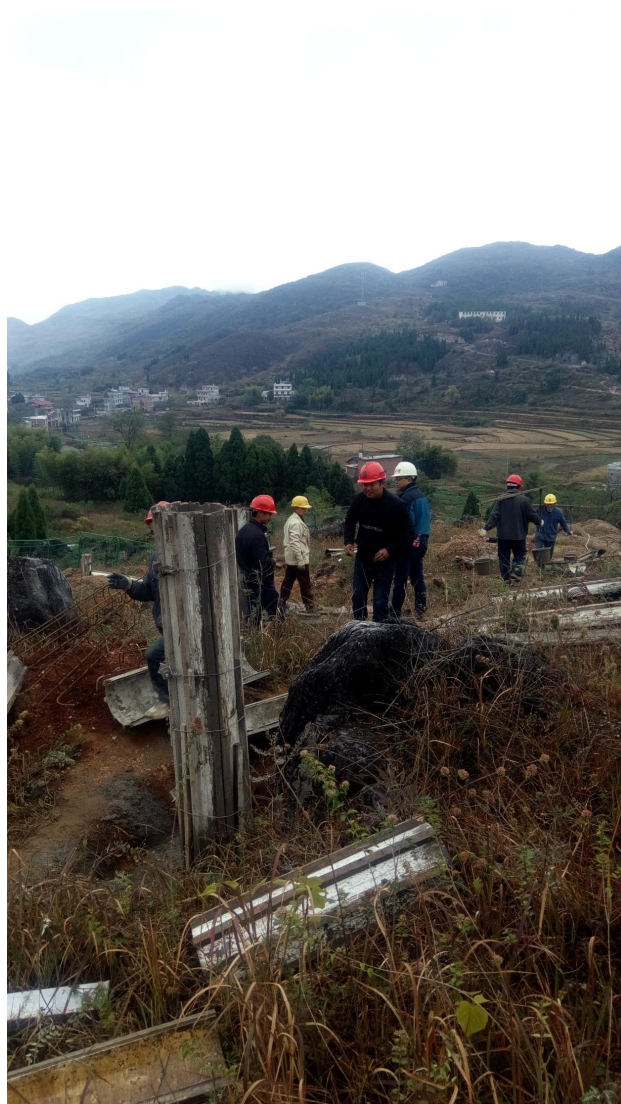
2017 年 11 月 14 日柏杨光伏区 14 子阵基础施工
