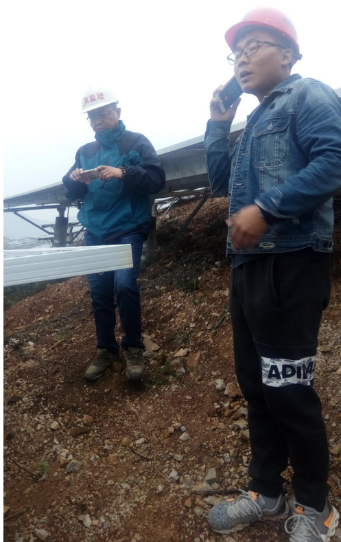
2017 年 11 月 11 日柏杨光伏区组件检查
