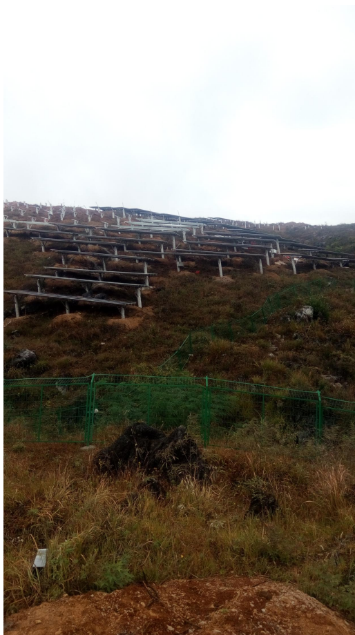
2017 年 11 月 20 日柏杨光伏区 17 子阵支架组件安装
