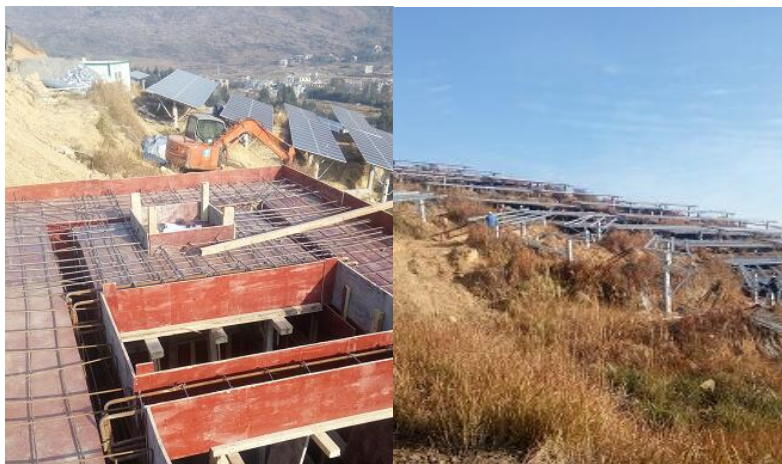
2017 年 12 月 21 日红联光伏区 9#箱变基础钢筋工程验收
