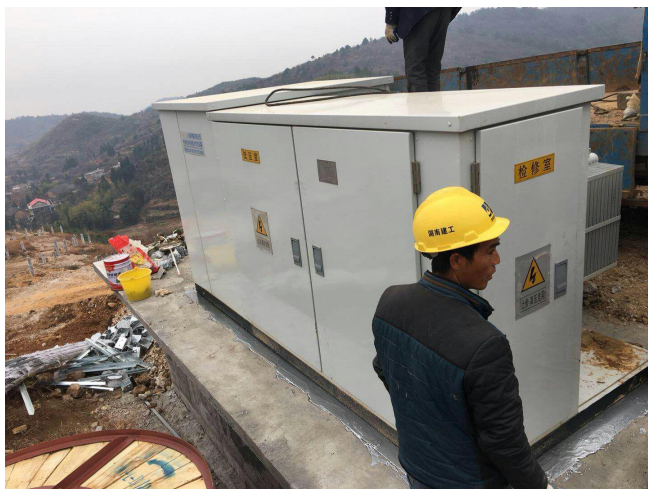
2017年12月27日柏杨光伏区9号箱变吊装
