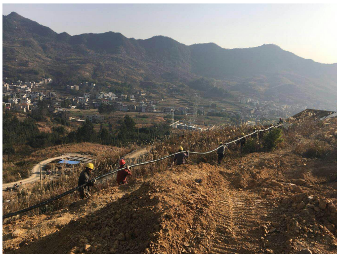
2017年12月25日12#-9#箱变高压电缆敷设
