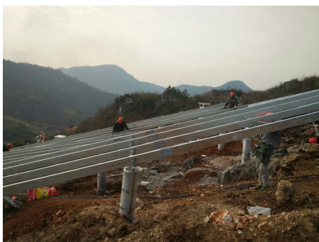
2018 年 01 月 17 日柏杨光伏区 9 子阵支架安装
