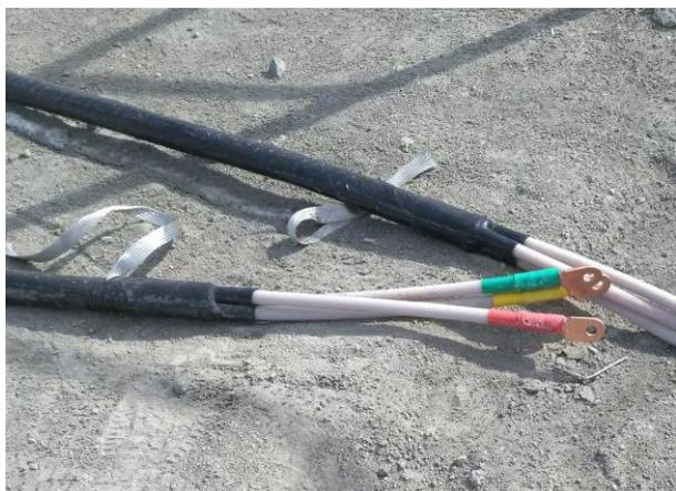
电缆头裸漏没有采取防水、防潮、保护措施
