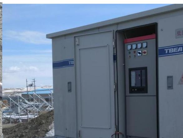
工作完后没有关箱变门（没做好成品保护）
