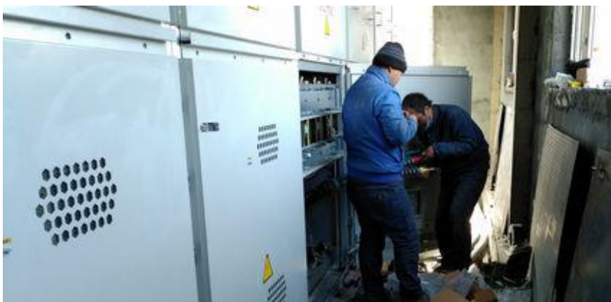
开关站电气设备检查
