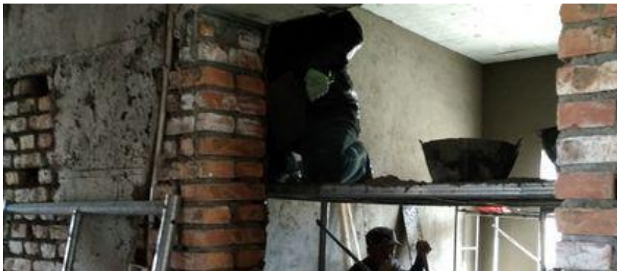
办公楼内墙粉刷
