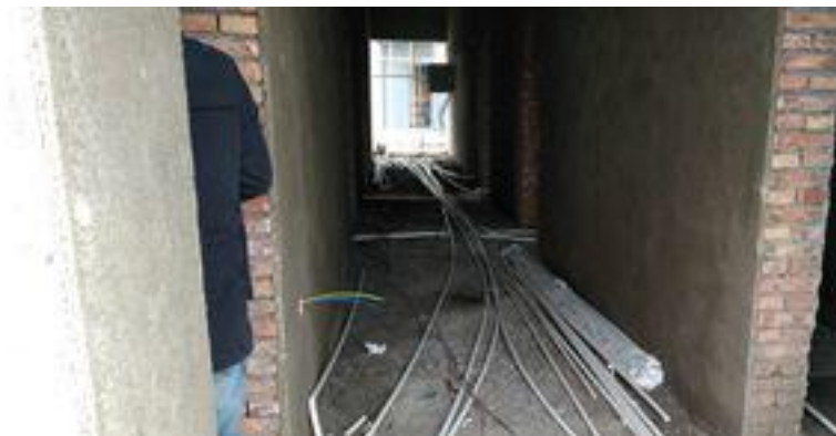
办公楼照管敷设、穿线
