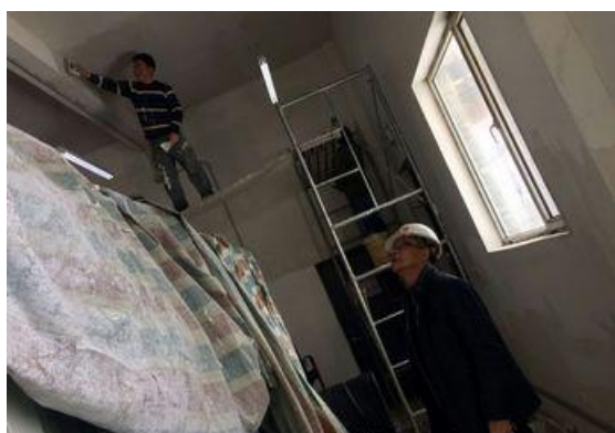
开关站内墙粉刷
