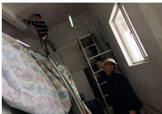
开关站内墙粉刷
