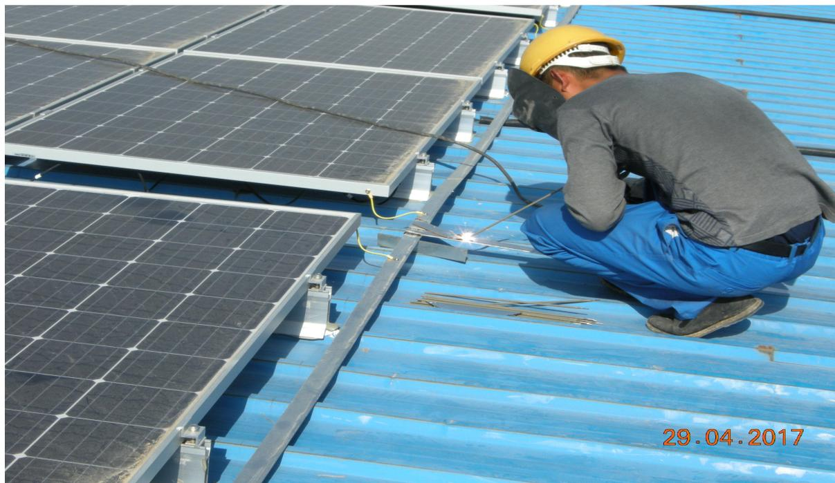
现场安装静电接地装置。
