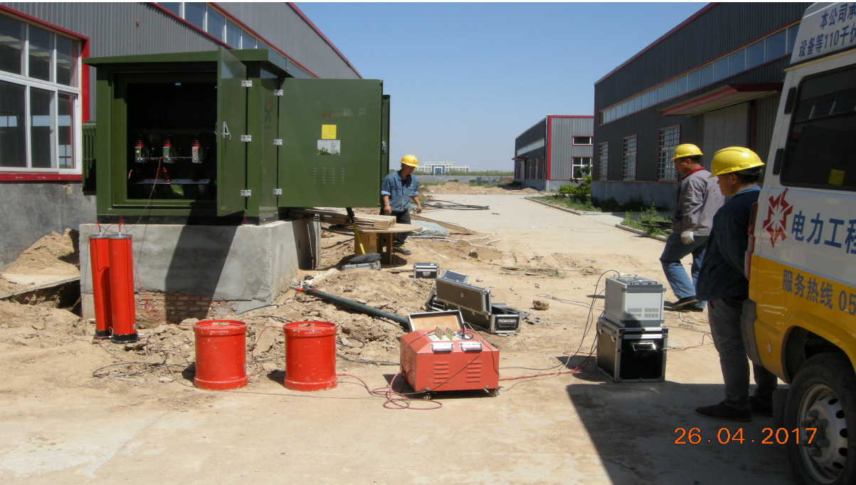
箱变高压部分进行试压。
