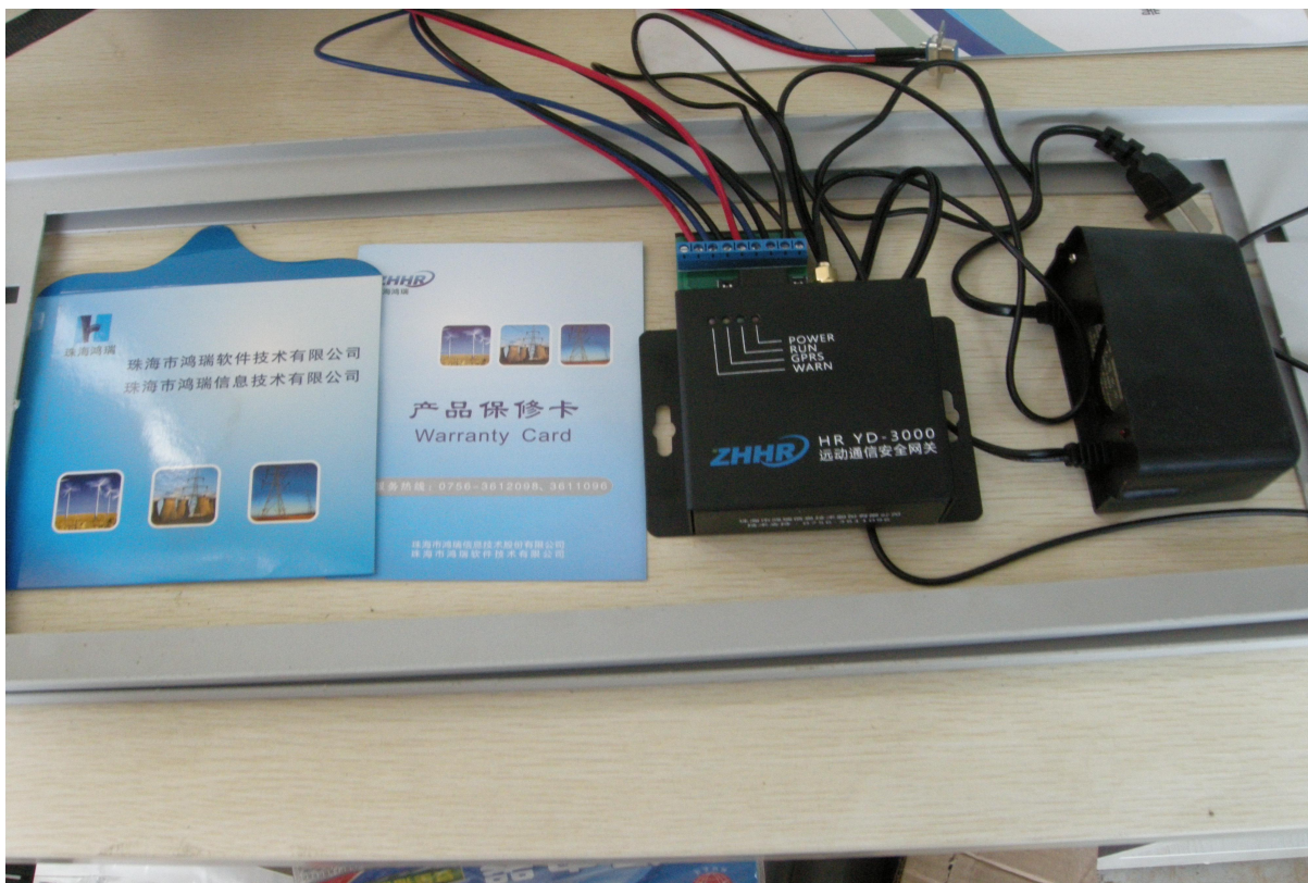
开关站：无线网络采集卡安装调试完成。（联通）
