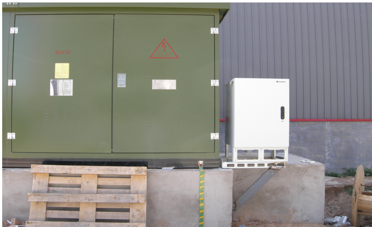
箱变旁边配置数据采集柜整体安装完成。
