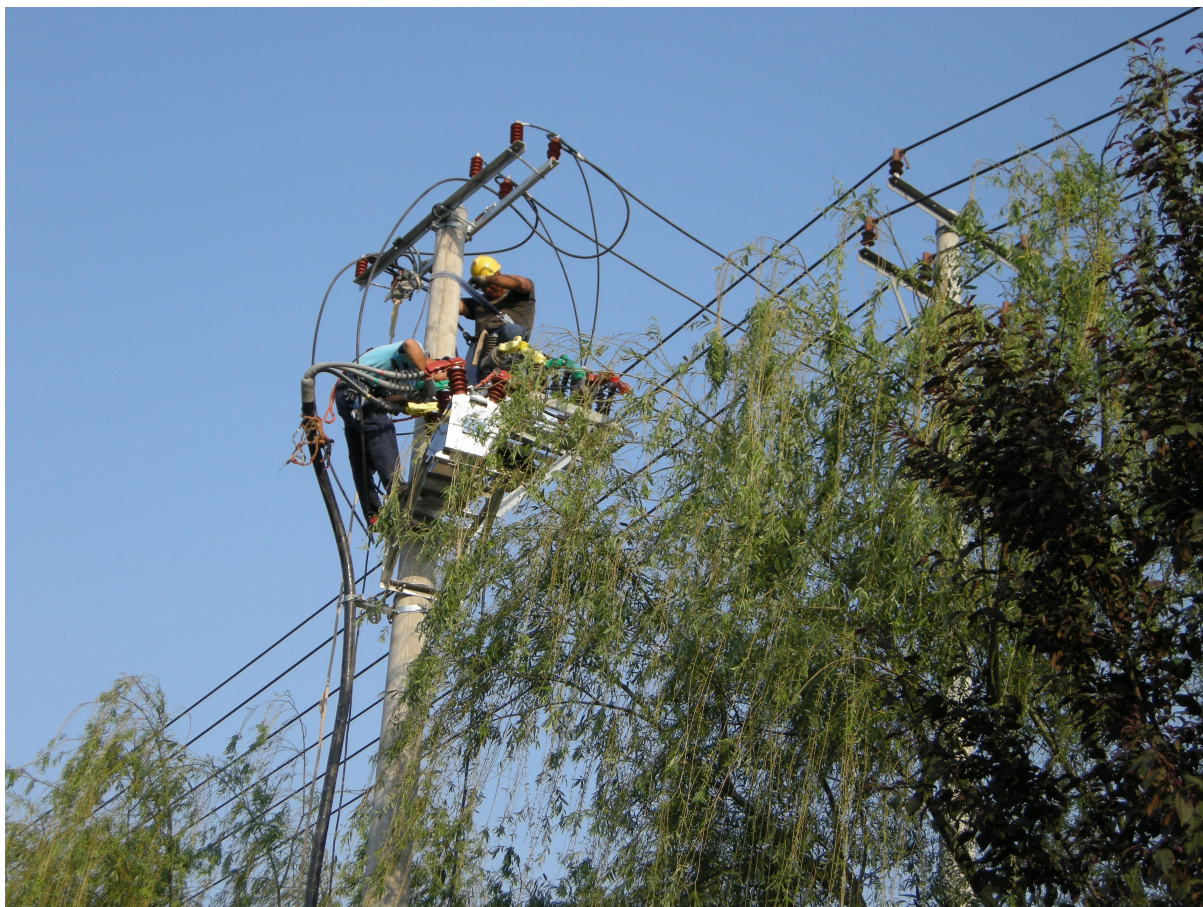
外线安装电气设备准备达火。
