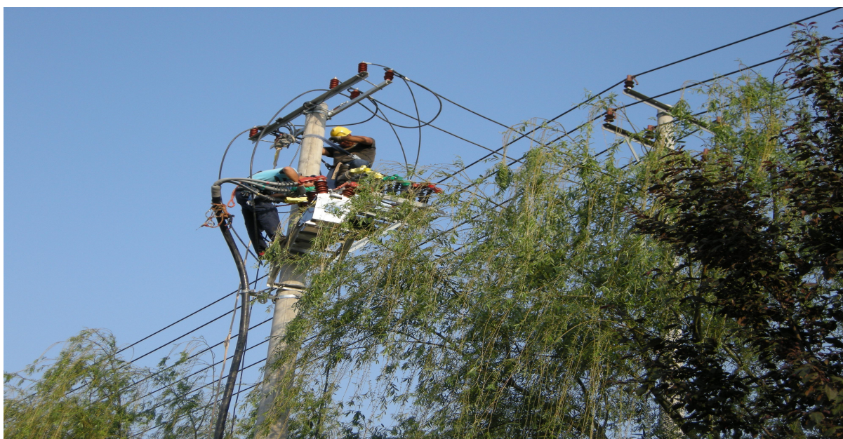
外线安装电气设备和接线。
