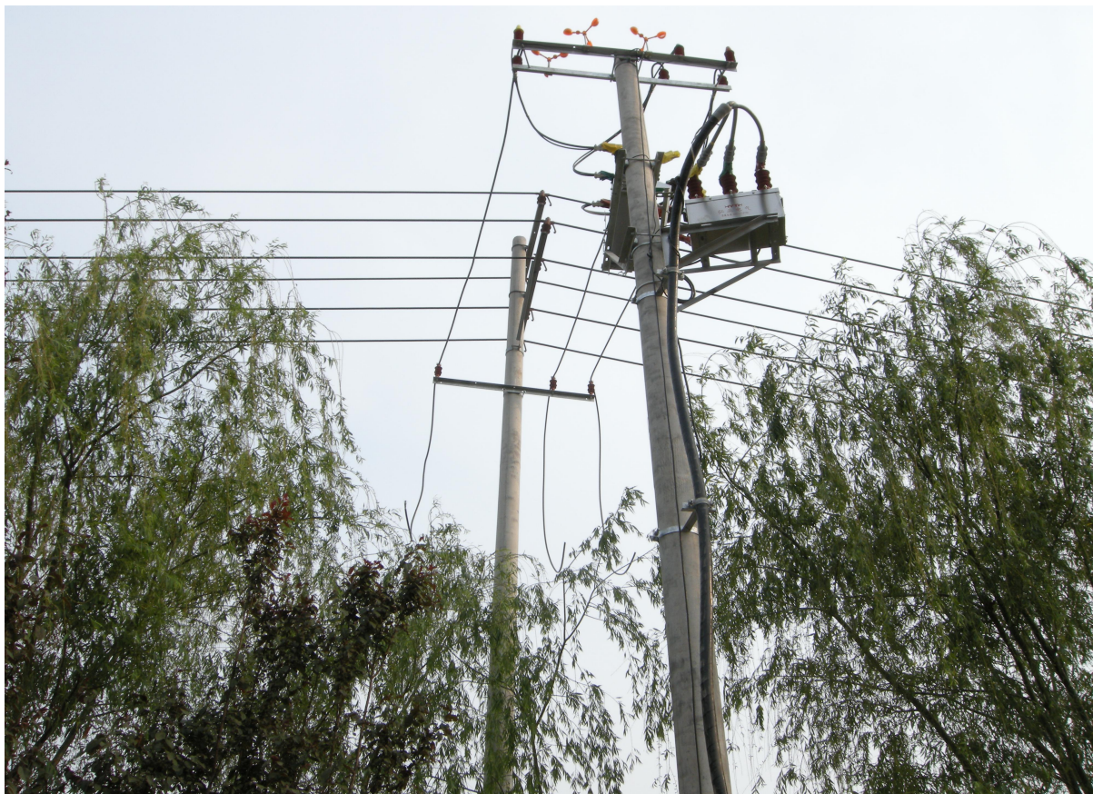
接线已到位，等待供电局停电，T 接正源线。
