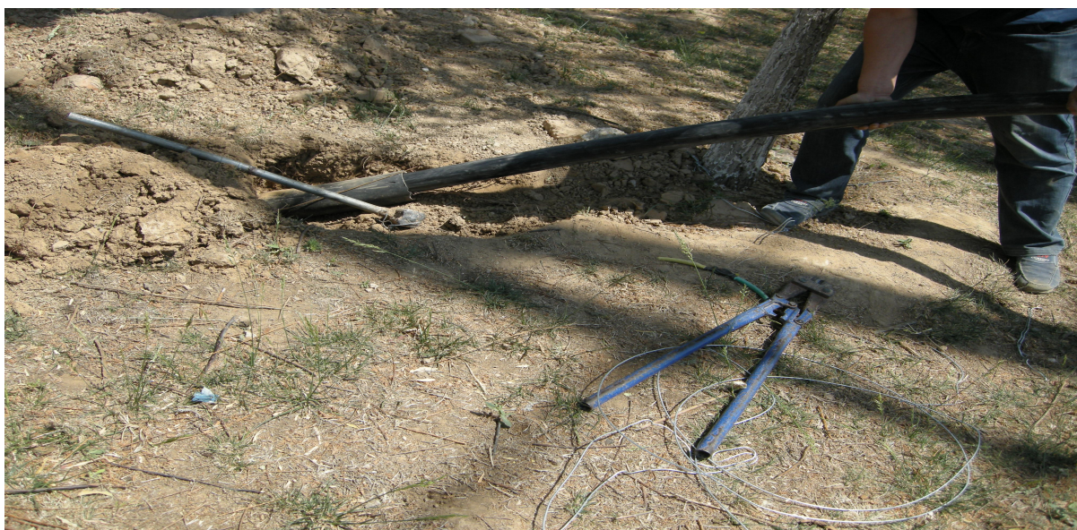
外线安装过路穿线高压电缆。
