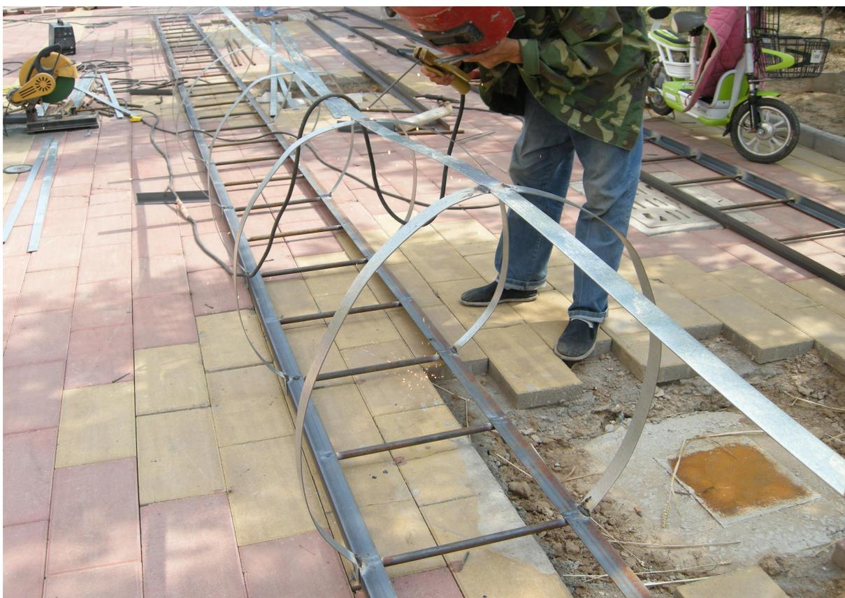
同创：预制厂房外的爬梯，安装完成后准备敷设光纤和电源电缆。
