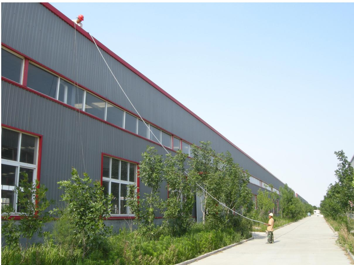
维特新：往从房顶上敷设光纤和电源电缆，电缆已穿在套管里。
