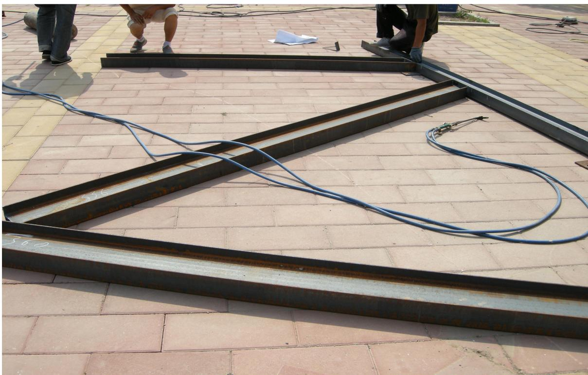
同创：办公楼前预制车棚钢结构骨架，车棚顶上安装组件。
