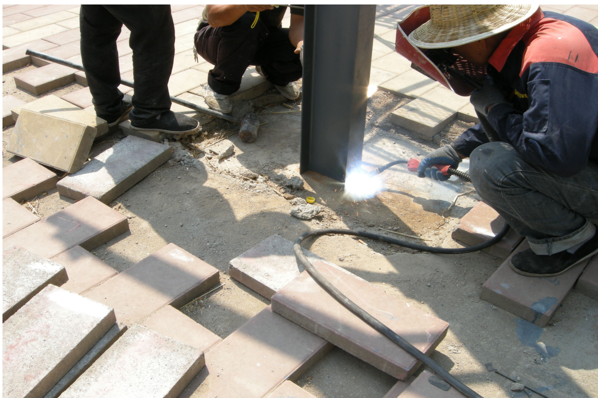
车棚钢结构安装组对焊接施工过程中。
