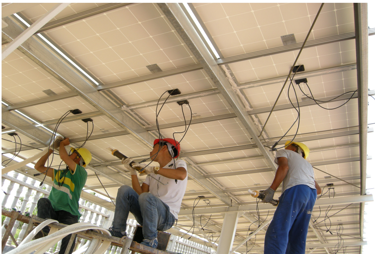
美凯华车棚是的组件堵缝隙施工
