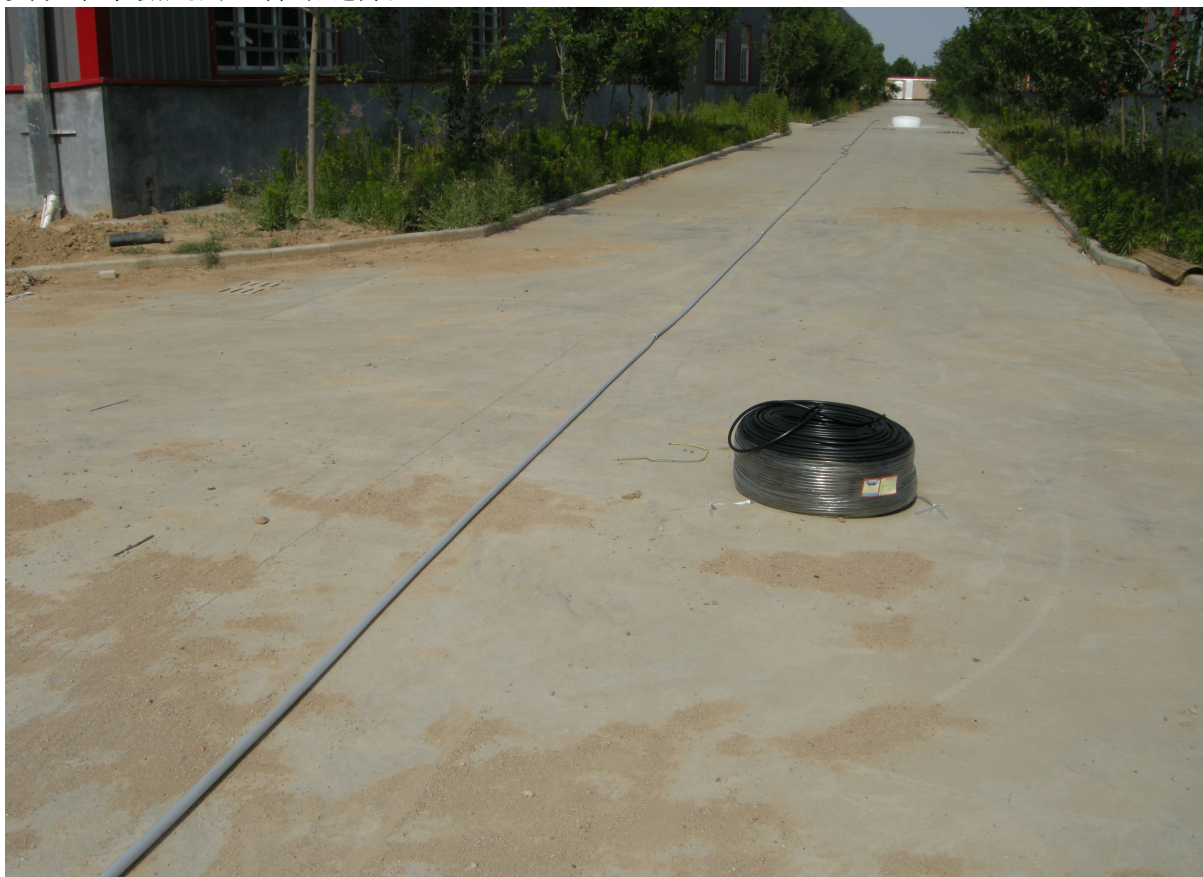
全厂区敷设光纤和电源电缆，这是两条电缆穿在套管内后，然后在往房顶上敷设。
