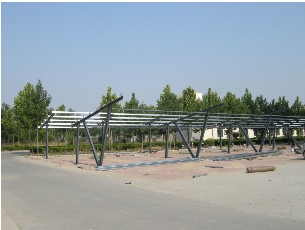
同创车棚安装完成。
