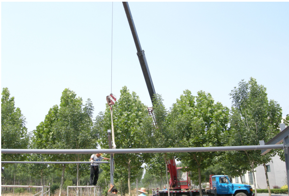
同创车棚安装组对焊接过程中，使用吊车配合施工。
