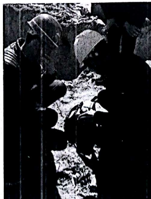
p2 区回填前测试主网接地 0.2 欧
