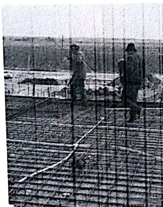
P2 区电气屋面钢筋绑扎
