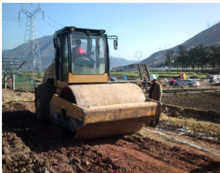
渔业设施土方回填及压实
