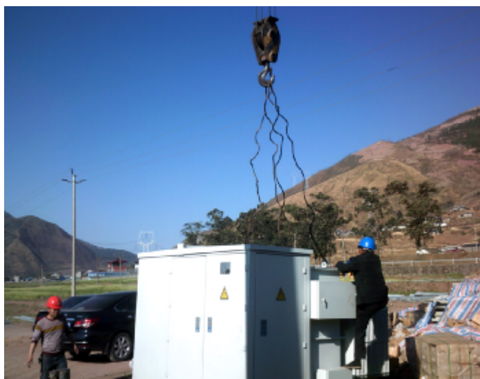
箱变设备到货并吊装作业
