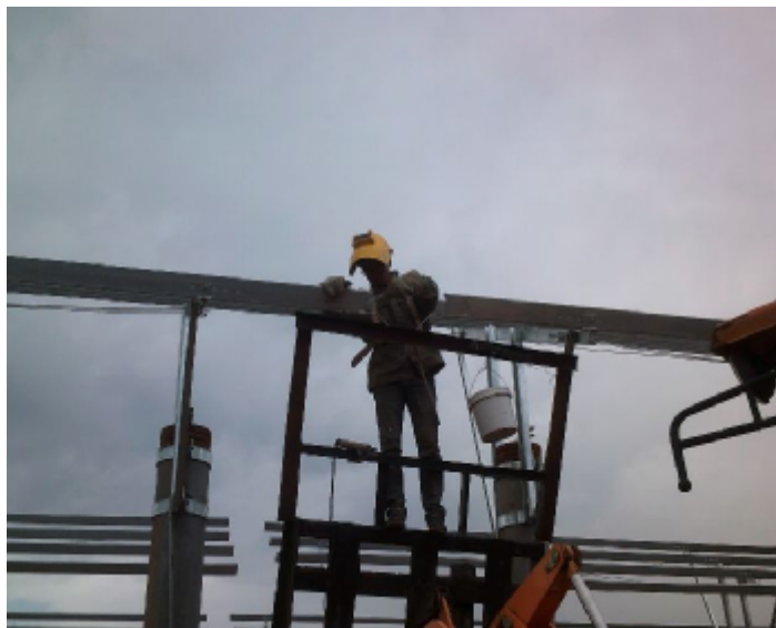
光伏阵列间接地焊接
