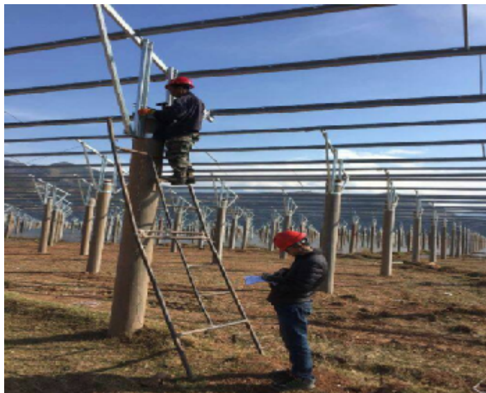
光伏区桩基低应变检测
