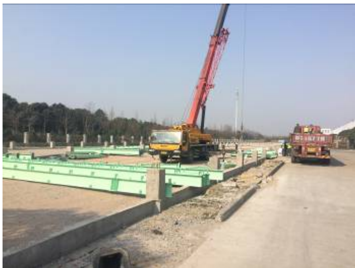
钢构材料的到场卸货
