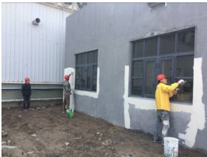
开关站外墙的粉刷
