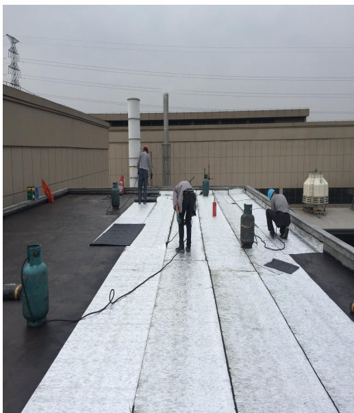
开关站屋面防水施工
