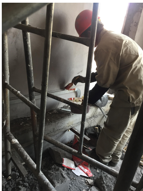
开关站接地防腐施工
