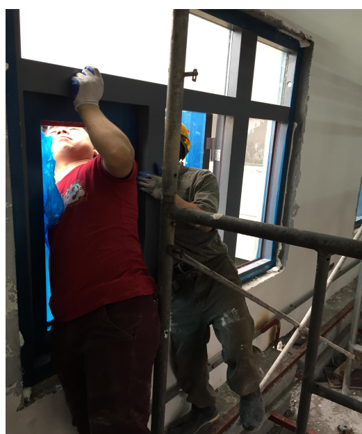
开关站门窗安装
