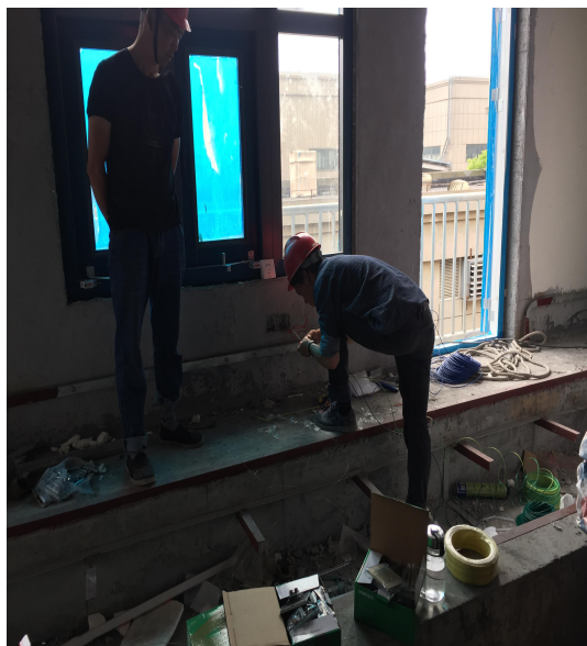
开关站线盒穿线
