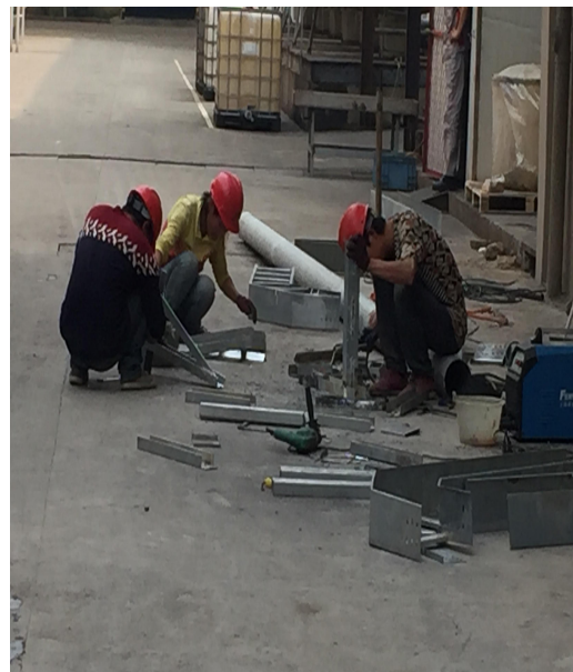
桥架支架加工
