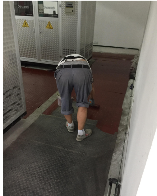
开关站钢盖板地坪刷漆施工
