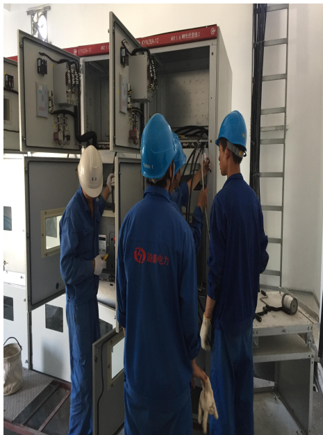
开关站设备接线施工
