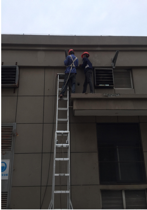
开关站至厂方配电室桥架安装
