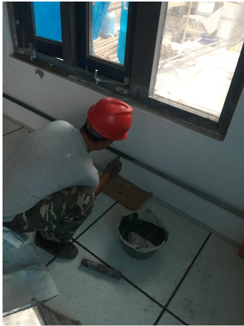
开关站室内接地防腐施工
