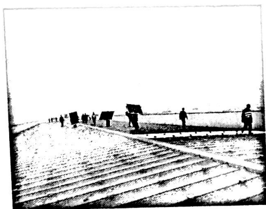
开关站一层顶板钢筋绑扎
