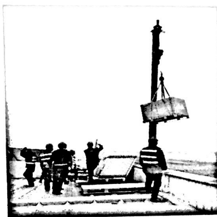
2#厂房组件吊装
