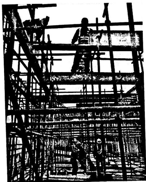
开关站一层钢筋检验收
