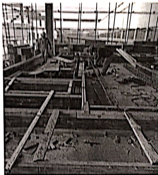
开关站电缆沟钢筋绑扎
