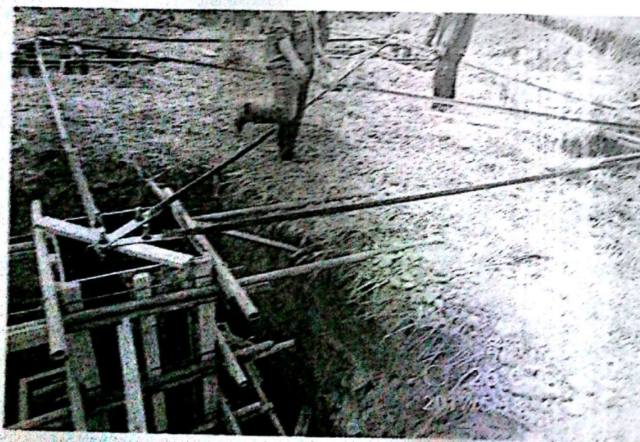
外线 110kv 塔基基础支护模板
