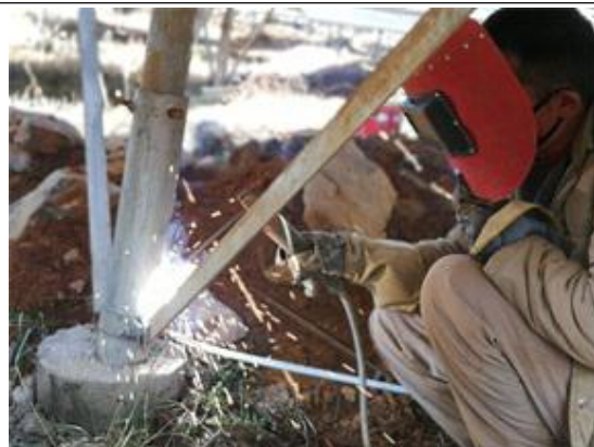
光伏东区 20 号方阵场区接地扁铁焊接
