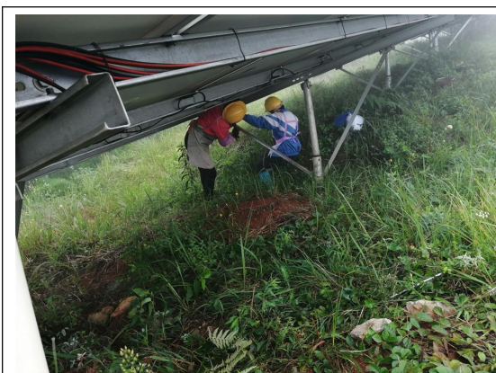
6-7 号方阵生锈螺栓更换
