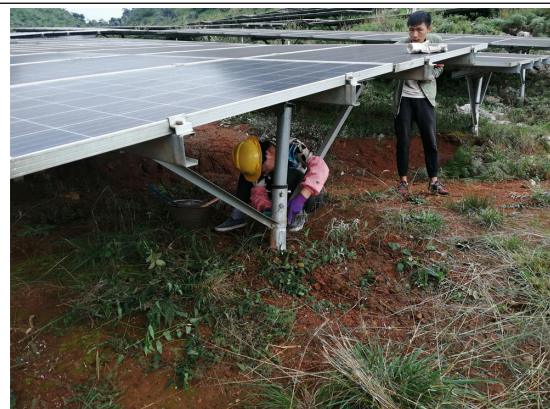
6-7 号方阵生锈螺栓更换
