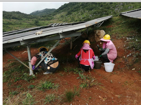
6-7 号方阵生锈螺栓更换
