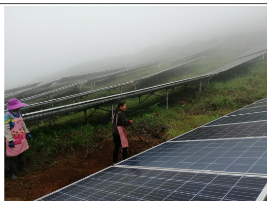
6-7 号方阵生锈螺栓更换
