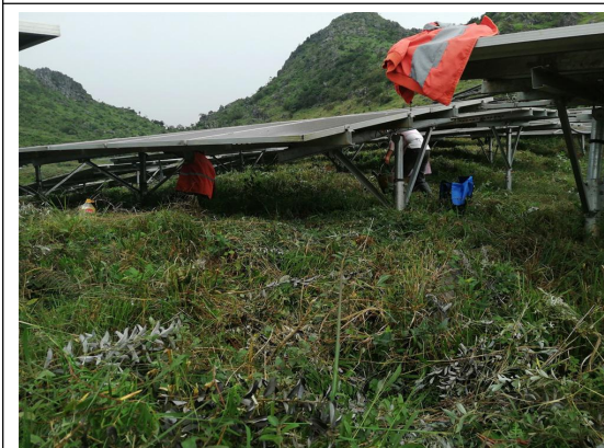
6-7 号方阵生锈螺栓更换
