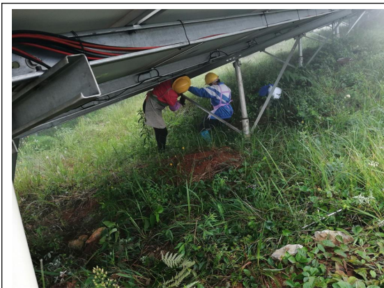
1-2 号方阵生锈螺栓更换
