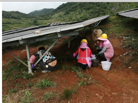
5 号方阵生锈螺栓更换
