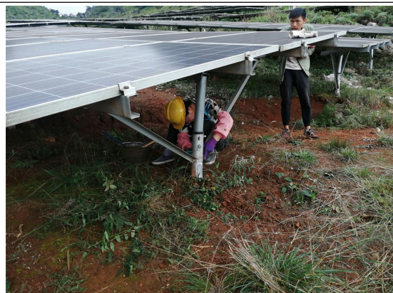
6-7 号方阵生锈螺栓更换
