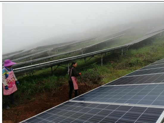
3-4-7 号方阵生锈螺栓更换
