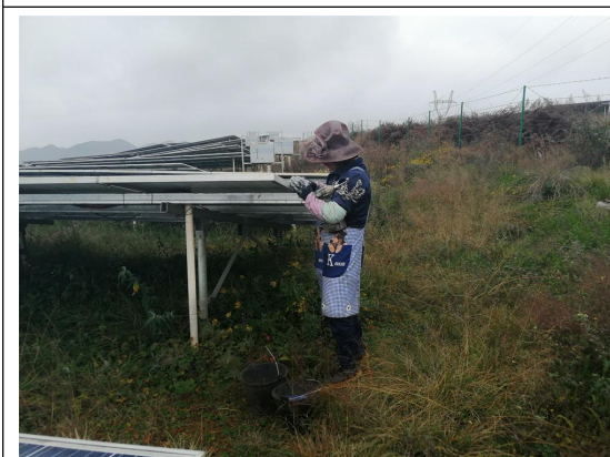
组件压块生锈螺栓更换
