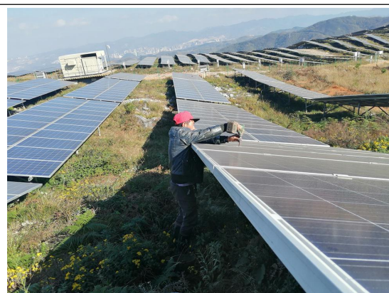
组件压块生锈螺栓更换
