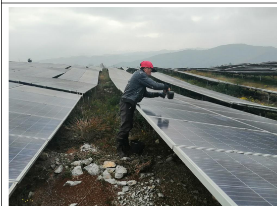
组件压块生锈螺栓更换
