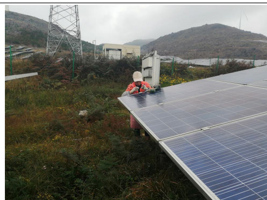
组件压块生锈螺栓更换
