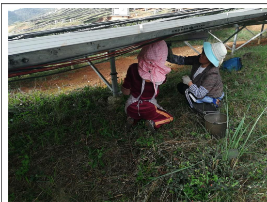
南区 8 号方阵前期安装问题支架整改
