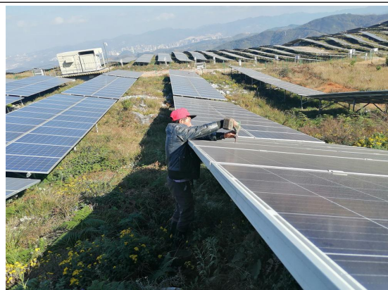
组件压块生锈螺栓更换
