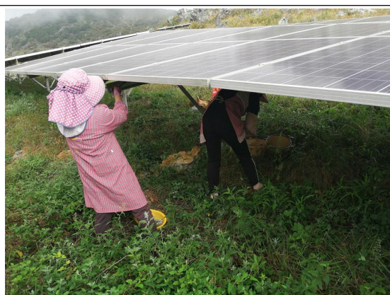
南区 8 号方阵前期安装问题支架整改
