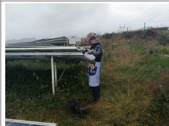
组件压块生锈螺栓更换
