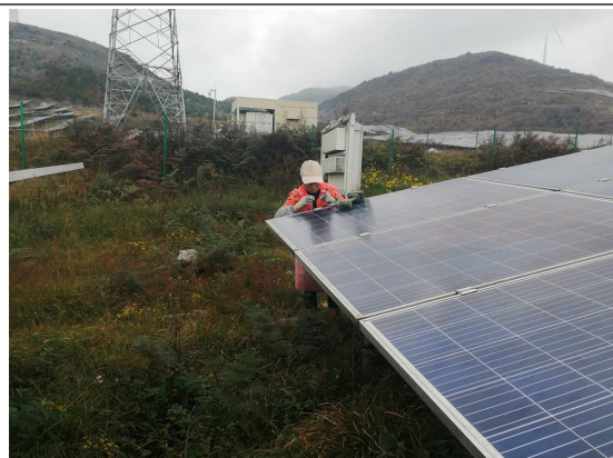
组件压块生锈螺栓更换
