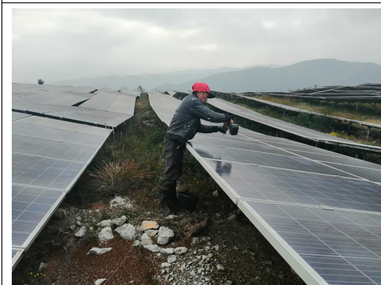
组件压块生锈螺栓更换
