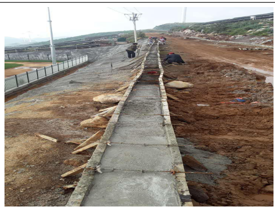
升压站护坡道路边排洪沟模具支护
