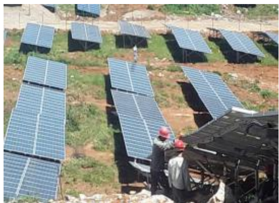
光伏区 15#方阵支架、组件倾斜角度整改
