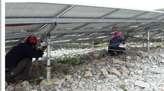
光伏区 12#方阵支架背拉杆调试
