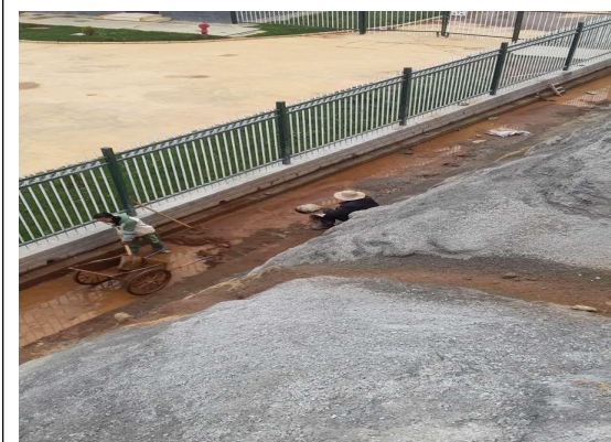
升压站护坡四周排水沟基槽内清理
