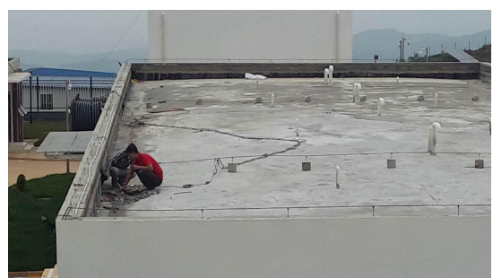
生产办公楼屋面防水层修补
