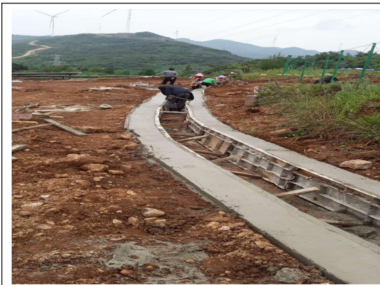
光伏区 9#方阵场区排洪沟浇筑混凝土
