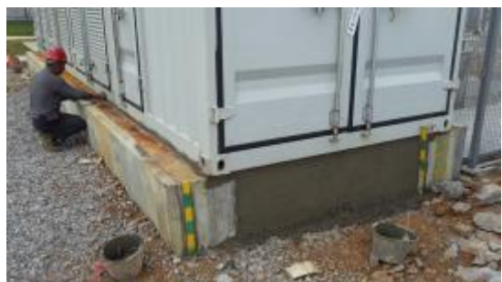
升压站 35kV 室外 SVG 设备基础封堵
