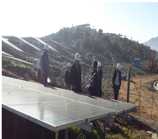
初验光伏区 15#至 13#方阵施工质量
